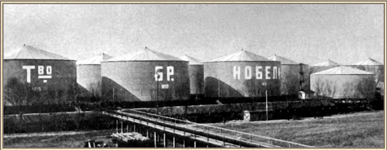
Həştərxanda “Nobel Qardaşları” şirkətinə məxsus rezervuarlar
